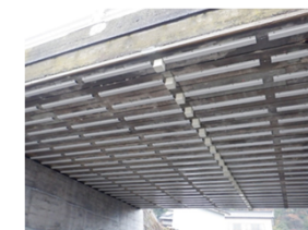
橋梁へのNAKAROD®施工例
