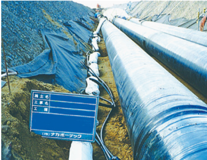
マグネシウム合金陽極で防食されているパイプライン
