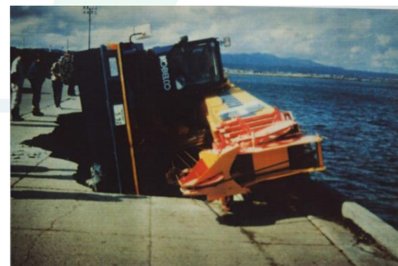
鋼矢板の腐食により穴が開き、中詰土砂が流出、上部エコンクリートが重量に耐えきれず陥没
