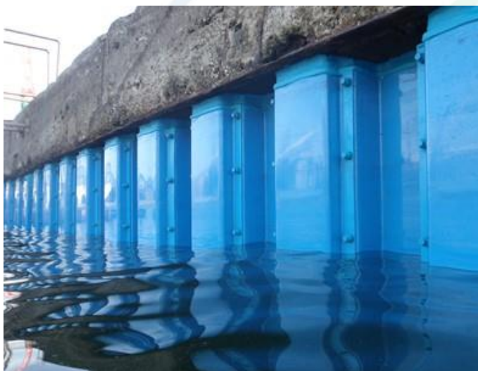
鋼矢板への適用事例（スタッドボルトタイプ：FRP）
