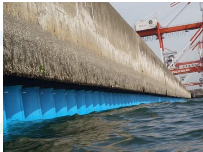
鋼管矢板への適用事例（スタッドボルトタイプ：FRP）
