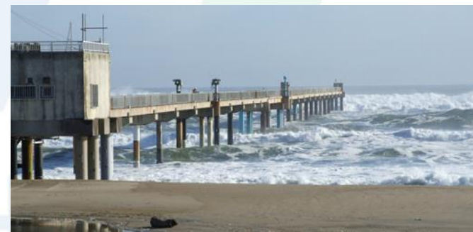
波崎海洋研究施設栈橋（暴露試験）
