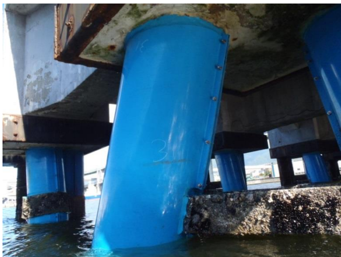
栈橋鋼管杭への適用事例（フランジタイプ：FRP）
