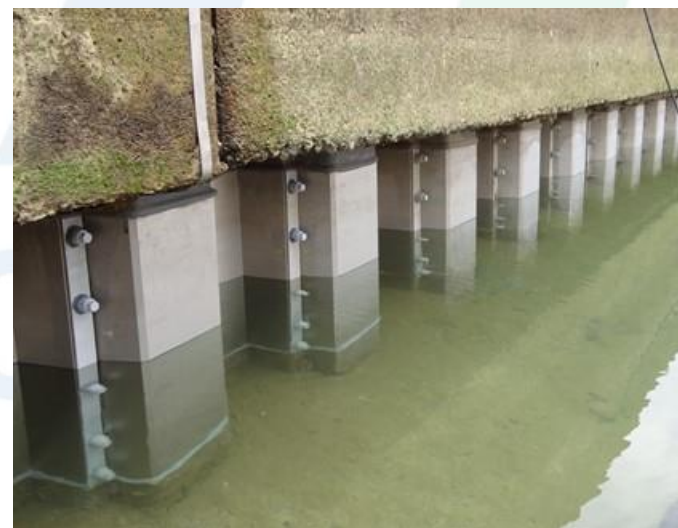
鋼矢板への適用事例（スタッドボルトタイプ：チタン）
