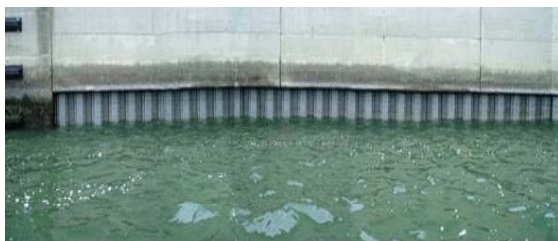
写真14 施工完了全景
