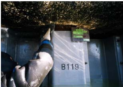
写真8 端部処理状況
