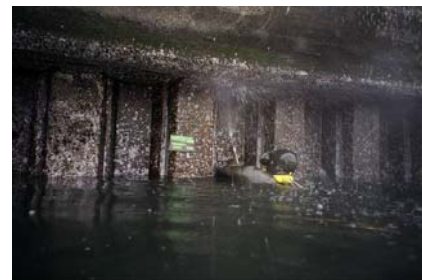
写真 2 下地処理状況
