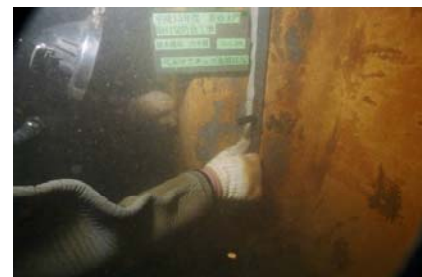
写真 4 ペトマスチック充填状況
