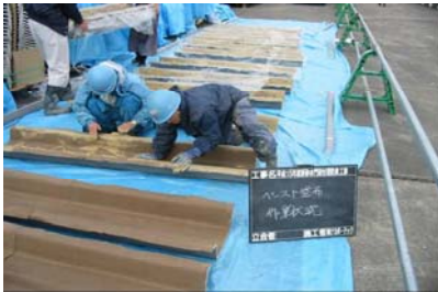
写真6 ペースト塗布状況
