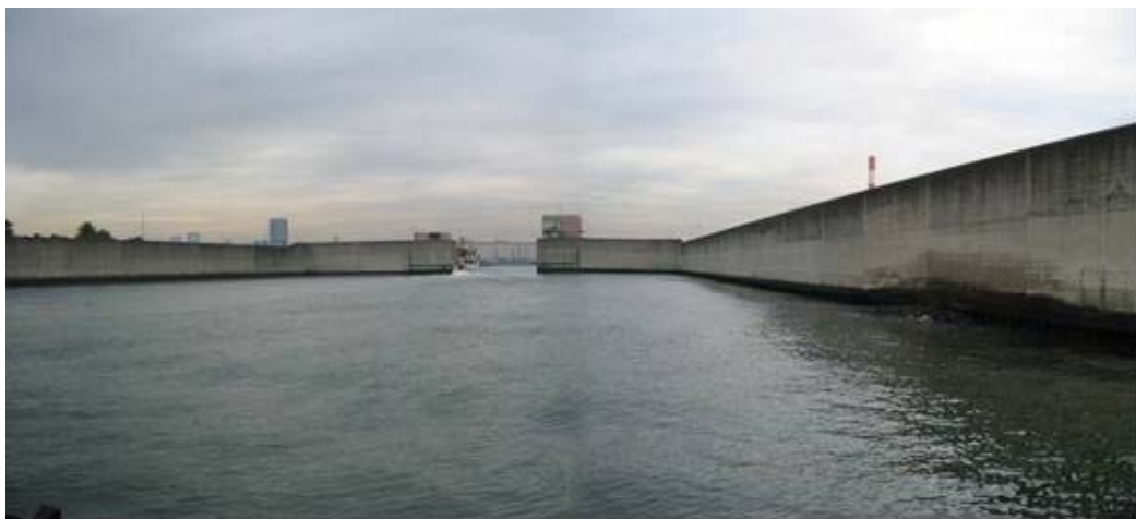
写真 1 新砂水門取付堤全景
