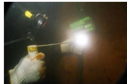
写真 3 ベースプレート取付状況
