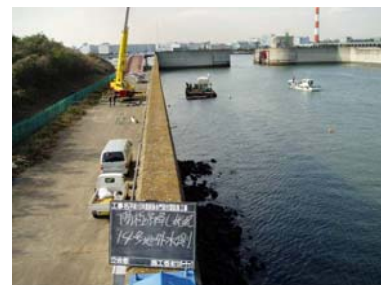
写真10 陽極吊下げ状況
