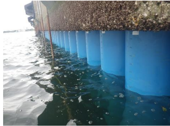
図8 ペトロラタム被覆完了
