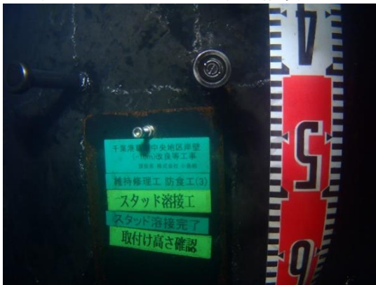
図 17 スタッドボルト溶接完了
