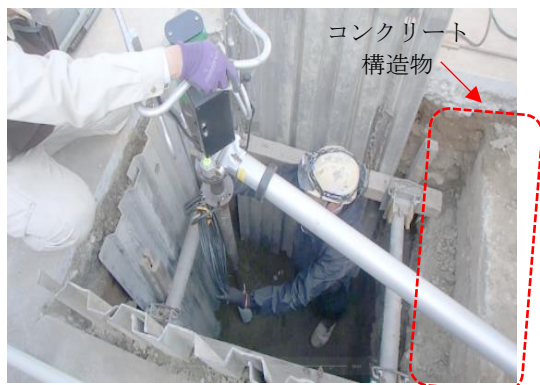
写真3 施工状況 奥側
