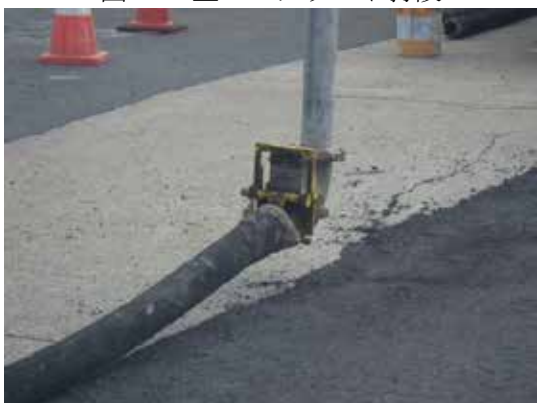
図 30 シャッター弁設置
