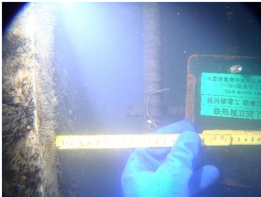
図 22 組立鉄筋かぶり厚さ確認
