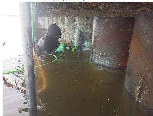
図7 水中硬化形被覆撤去
