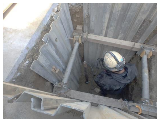
写真2 施工箇所 奥側
