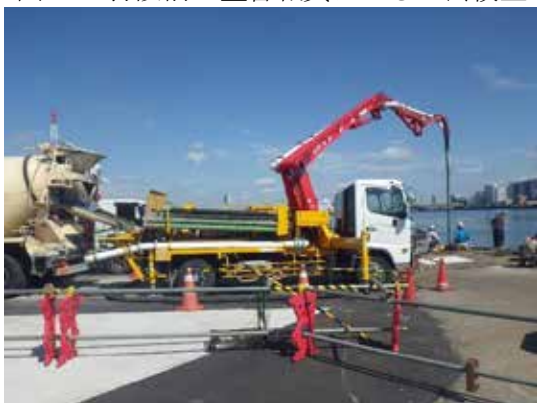
図 29 生コンクリート打設
