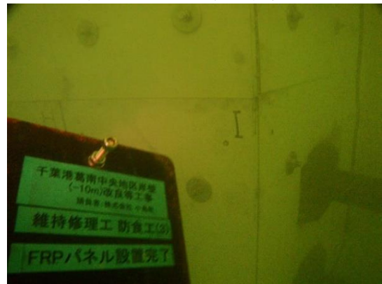
図 26 FRP パネル設置完了
