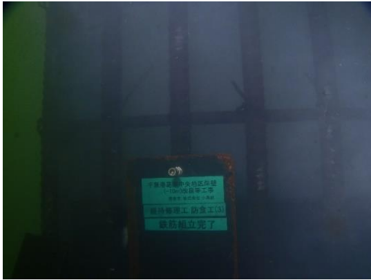
図 21 組立鉄筋設置完了
