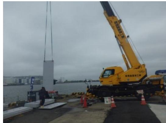
図 25 FRP パネル吊下げ
