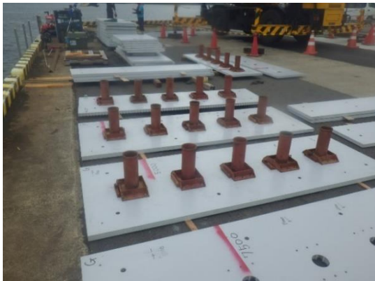
図 23 FRP パネル注入口(シャッター弁付)
