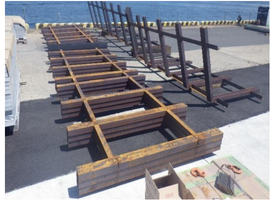
図 18 FRP パネル取付金具
