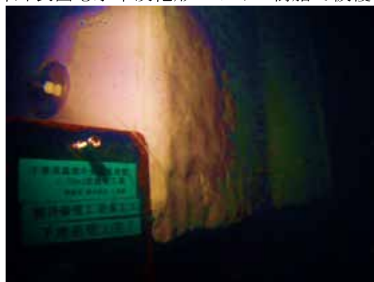
図 32 妻枠樹脂被覆完了
