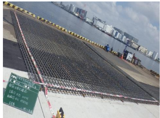
図 19 鉄筋加工組立完了
