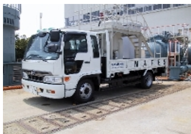
写真11. ユニット(トラック) 据付状況
