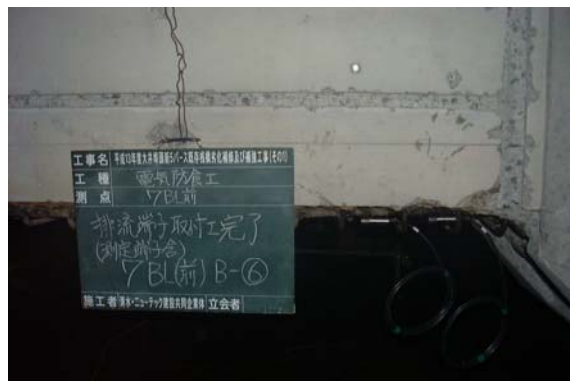
写真 3. 排流端子取付け状況
