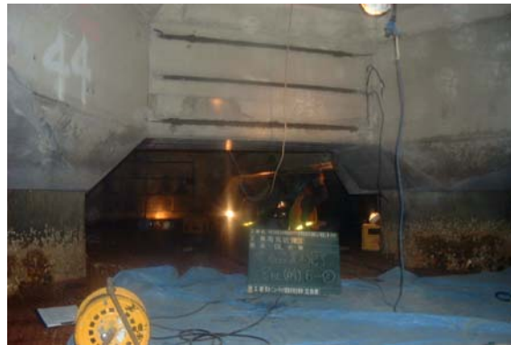
写真 2. 電極設置状況
