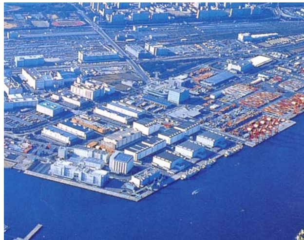
写真 1. 大井埠頭工事区域全景
