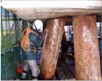
写真2 素地調整状況
