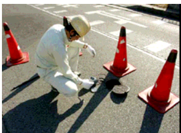
写真3 ポケレコ現場作業状況1
