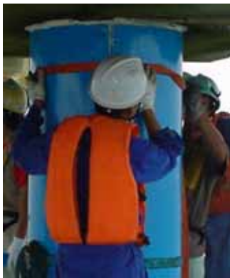
写真4 保護カバー取付状況
