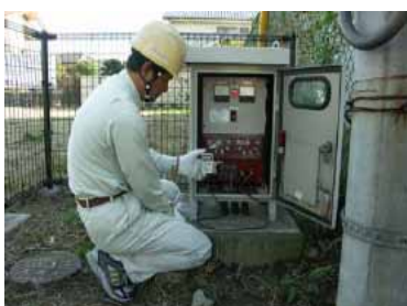
写真4 ポケレコ現場作業状況2
