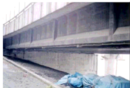
写真4 金波橋チタン溶射方式
