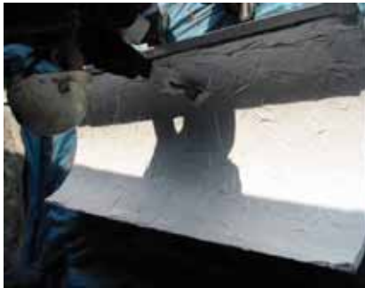
写真3 樹脂塗布状況
