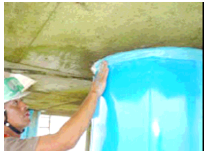
写真7 端部処理状況
