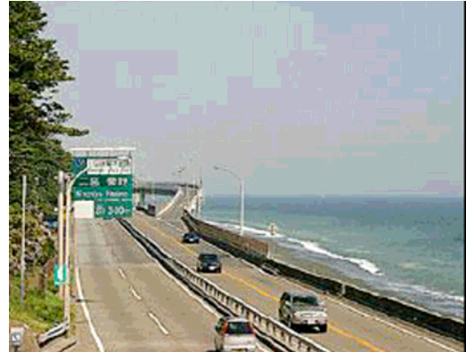
写真1 西湘バイパス全景
