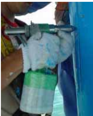
写真5 保護カバー固定状況
