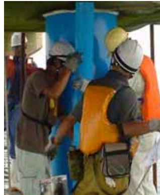
写真6 当板貼付状況
