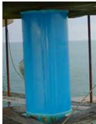
写真8 施工後外観状況
