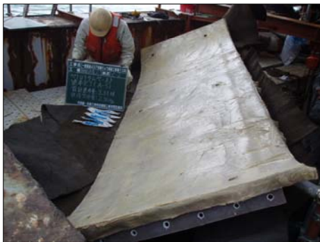
写真6 防食層+FRP カバー
