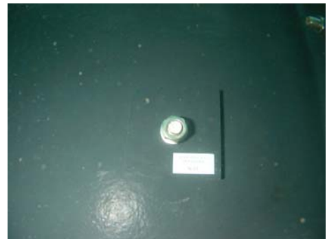
写真8 スタッドボルト固定部
