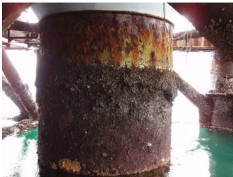
写真3 鋼管杭施工前
