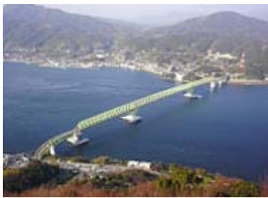
写真 1 大島大橋全景 (上空から)
