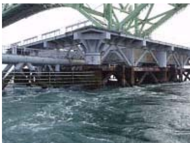
写真 2 P3 橋脚と付近の渦潮
