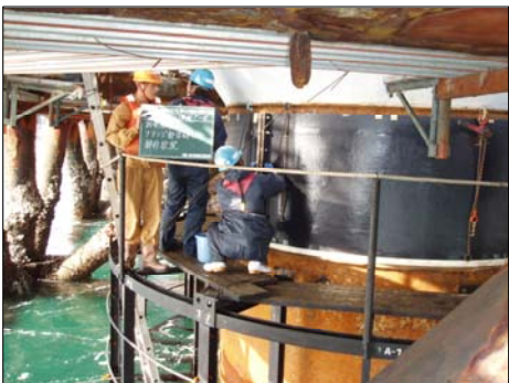
写真7 FRP カバー取付
