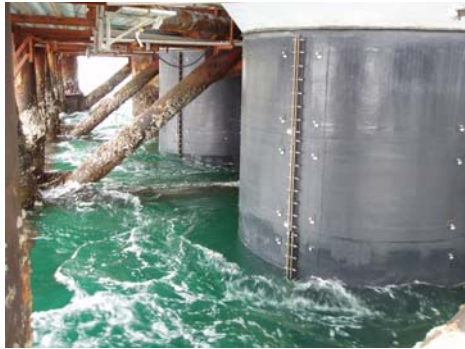
写真9 FRP カバー取付完了
