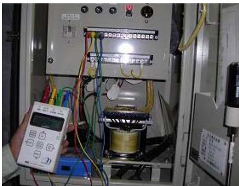
写真4 通電調整試験
