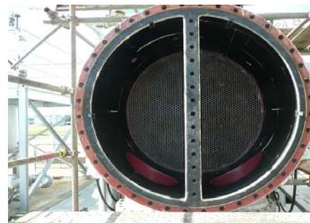
写真6 出入口側水室設置完了
