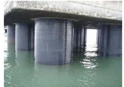
写真9 FRPカバー取付完了
