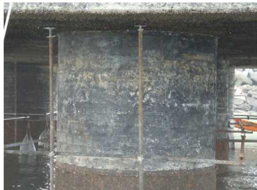
写真4 既設防食テープ撤去時の鋼管杭表面
