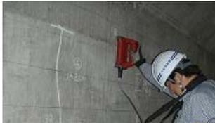
写真2 鉄筋探査状況
