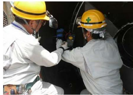
写真5 チタンシート導通絶縁確認
