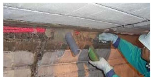
写真5 導水工施工
