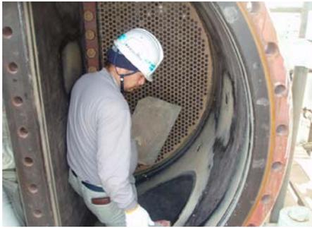
写真1 水室内面ゴムライニング平滑化加工
