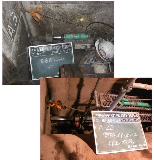
写真5 電極押し込み状況
