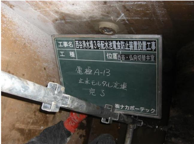
写真6 電極押し込み完了・止水処理
