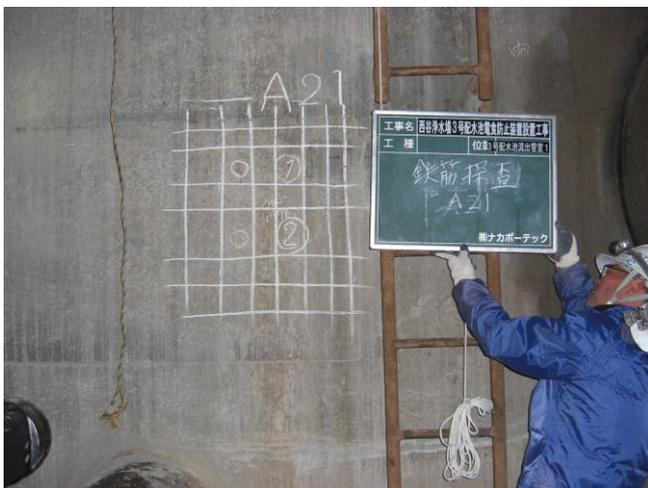
写真3 鉄筋探査によるマーキング
