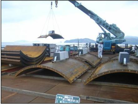
写真3 鋼製型枠にアルミニウム合金陽極を取付
