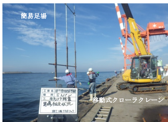
写真2. 足場設置状況
