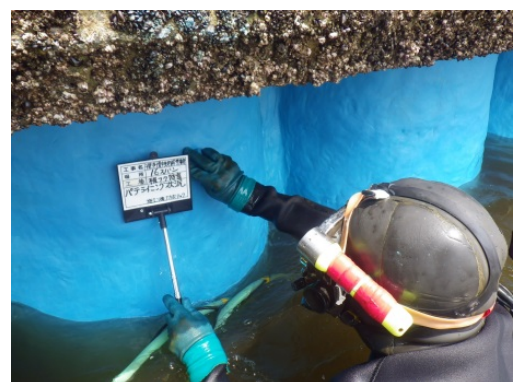
写真4. エポキシ樹脂塗布状況
