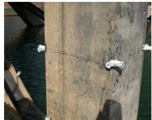
写真1 通電電極設置状況
