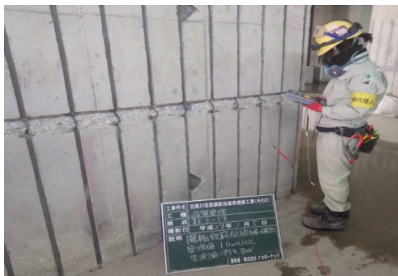
写真 4 陽極鉄筋間絶縁確認状況
