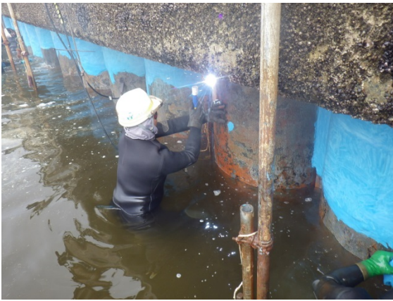
写真1 腐食孔閉塞施工状況
