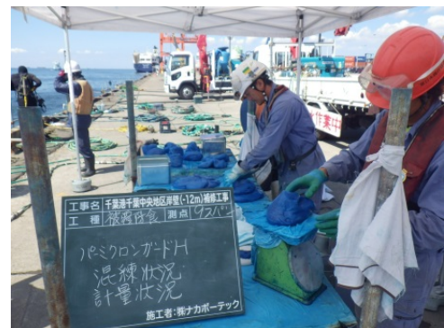
写真3. エポキシ樹脂混練状況
