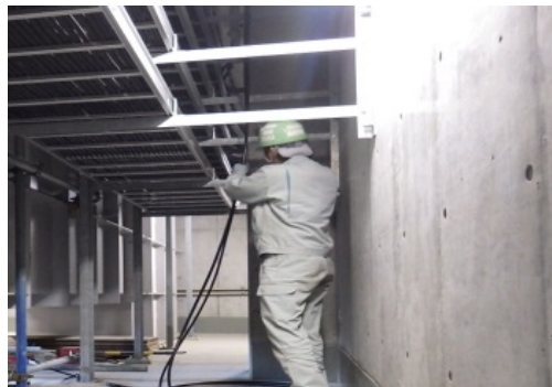
写真 6 ケーブル布設状況(施設 2 階)
