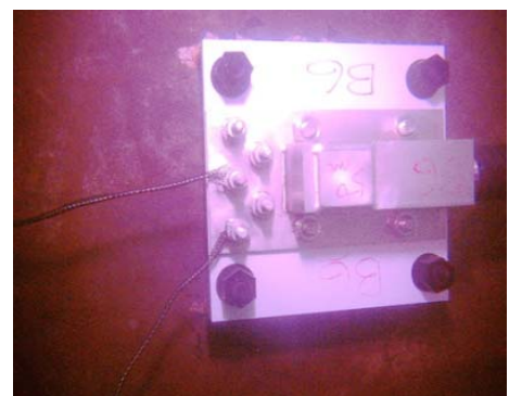
写真2 接続金具を用いた通電電極とケーブルの接続状況
