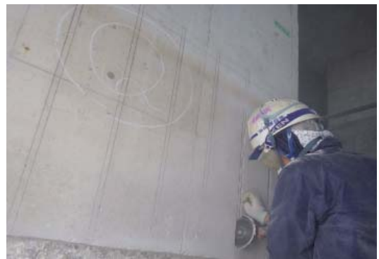
写真2 溝切はつり工
