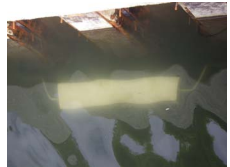
写真9 陽極取付完了
