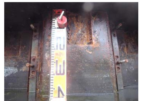
写真6 補強鋼板 取付完了
