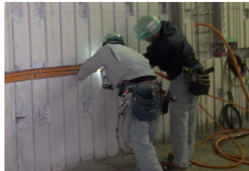
写真 5 CD 管設置状況(貯留池 1 層目)
