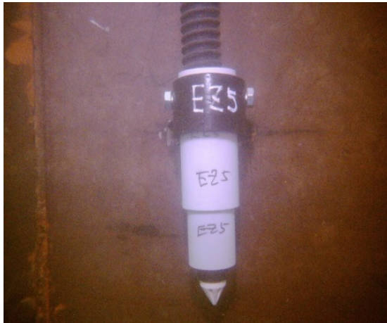
写真3 照合電極設置状況
