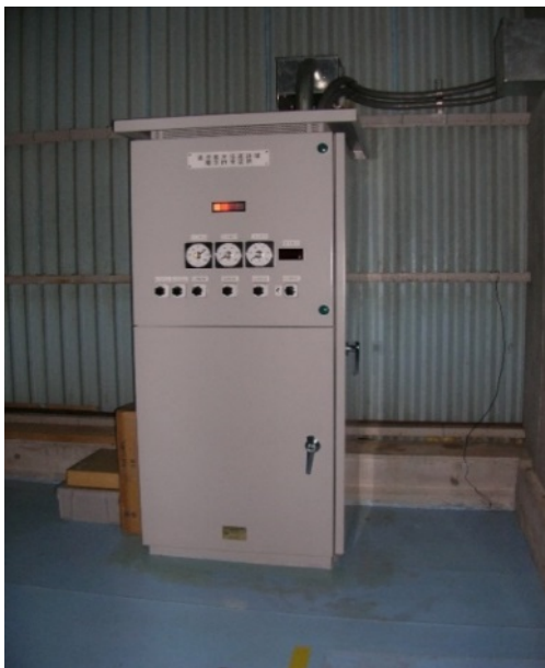
写真4 直流電源装置設置状況
