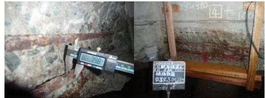
写真2 補強鉄筋溶接(D16)
