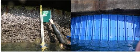
写真3 ペトロラタム被覆 施工前・完了
