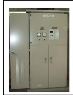
写真6 定電位自動制御方式直流電源装置
