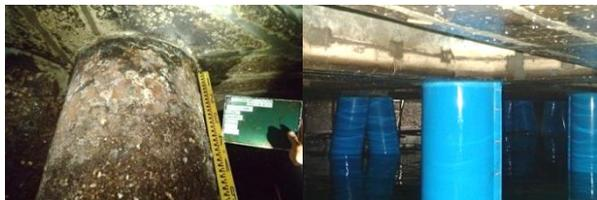
写真4 ペトロラタム被覆 施工前・完了
