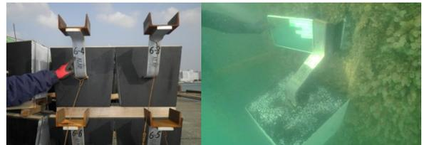
写真6 水中設置用陽極 納品時・取付後
