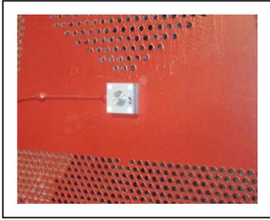
写真2 管板面への照合電極設置
