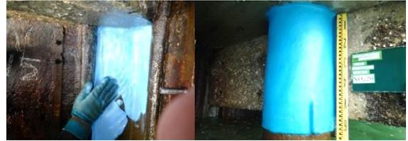
写真5 水中硬化形被覆 塗布・完成
