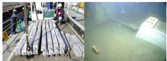
写真7 土中設置用陽極 施工時・取付後
