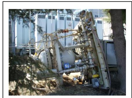
写真7 鉄イオン供給装置被災状況
