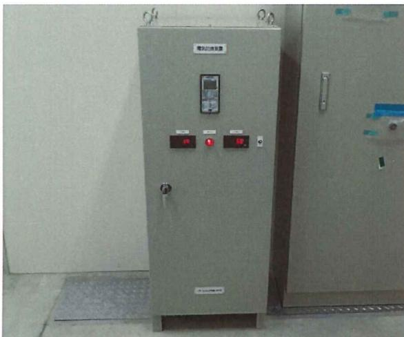
写真3 直流電源装置設置状況
