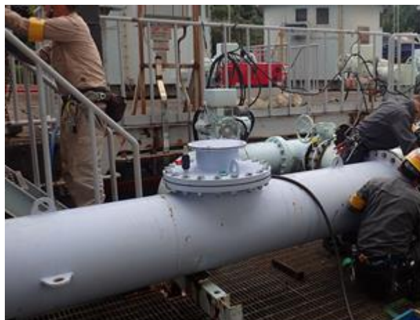
図10 電極設置状況
