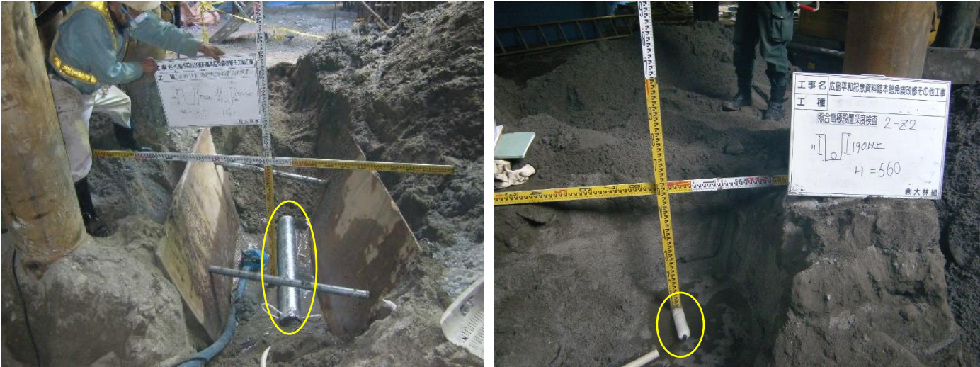
写真－1 施工状況
