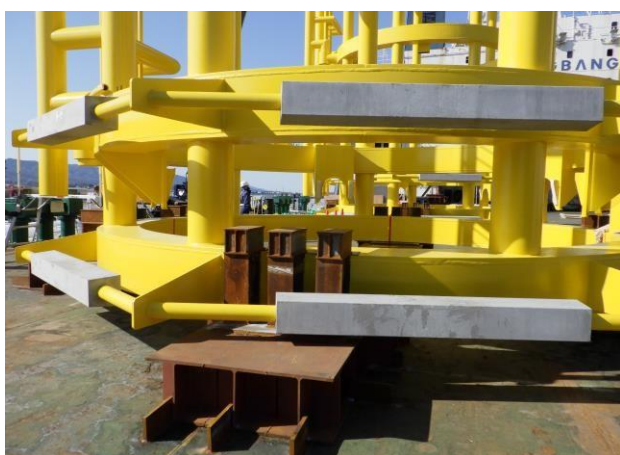
二次部材ケージに取り付けられたアルミニウム合金陽極
