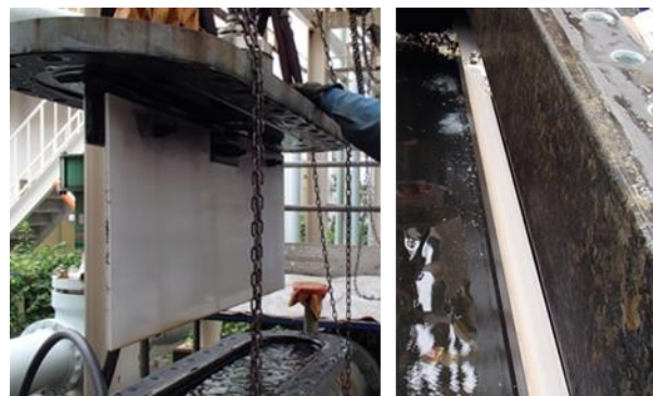
写真 5 電極開放点検
