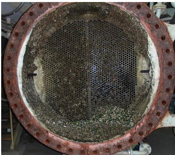
写真1 熱交換器付着事例
