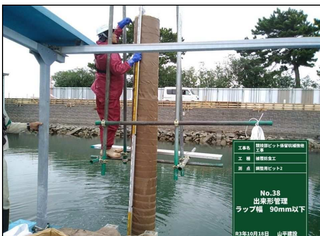
写真6 ペトロラタムテープ巻付け完了
