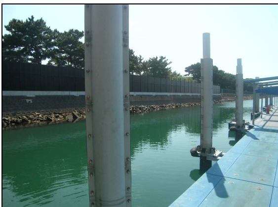
写真 13 施工後（全景）2 年経過時
