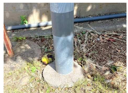
図 15 照明灯の支柱の地際部に ZAP テープを設置した事例
