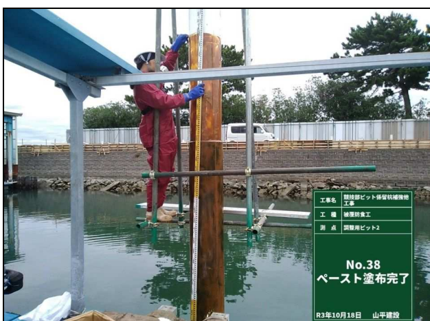
写真5 ペトロラタムペースト塗布完了
