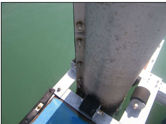
写真 14 施工後（ローラー部）2 年経過時
