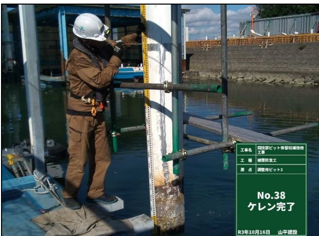
写真 2 下地処理完了
